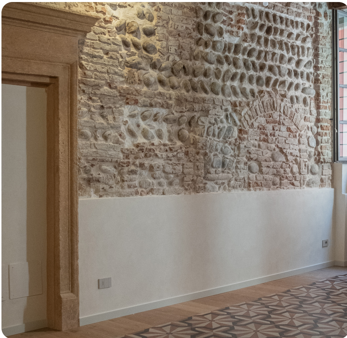
Vista dell'elegante tessitura muraria interna alla residenza
