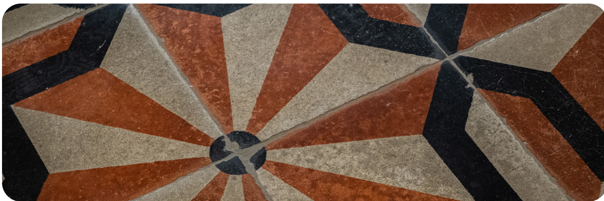
Dettaglio della decorazione del pavimento integrata
