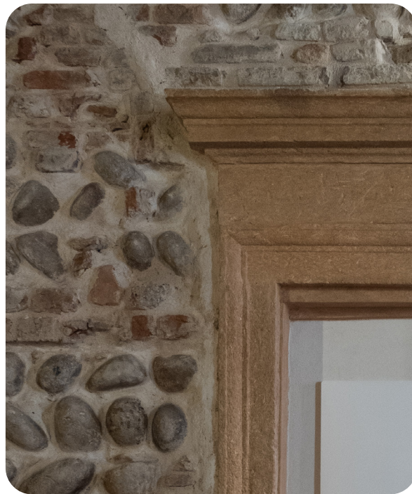
Tessitura muraria e cornici in pietra restaurate
