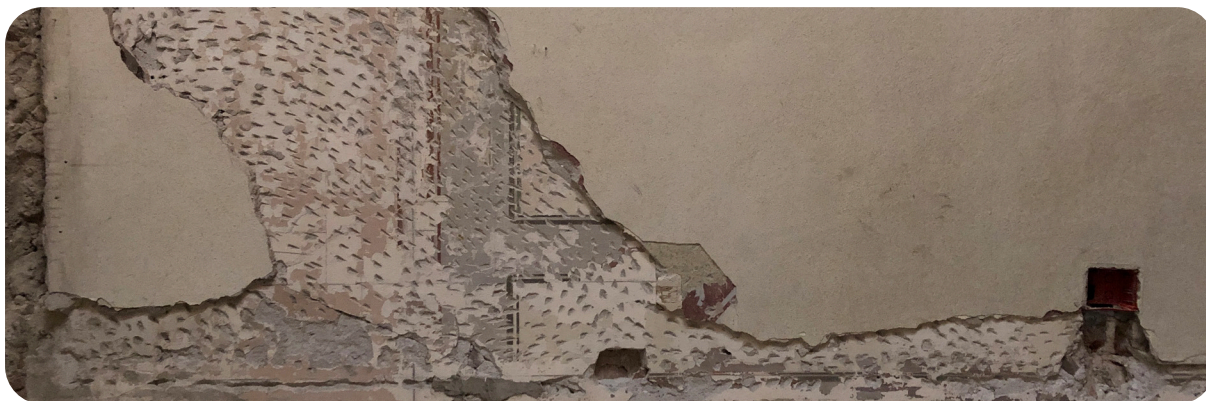
Demolizione controllata dell'intonaco per il recupero dell'apparato decorativo ad affresco
